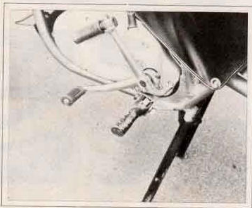
Perfettamente sistemati i comandi a pedale e pieghevoli in senso obliquo le robuste pedane metalliche dotate di molla di richiamo.
